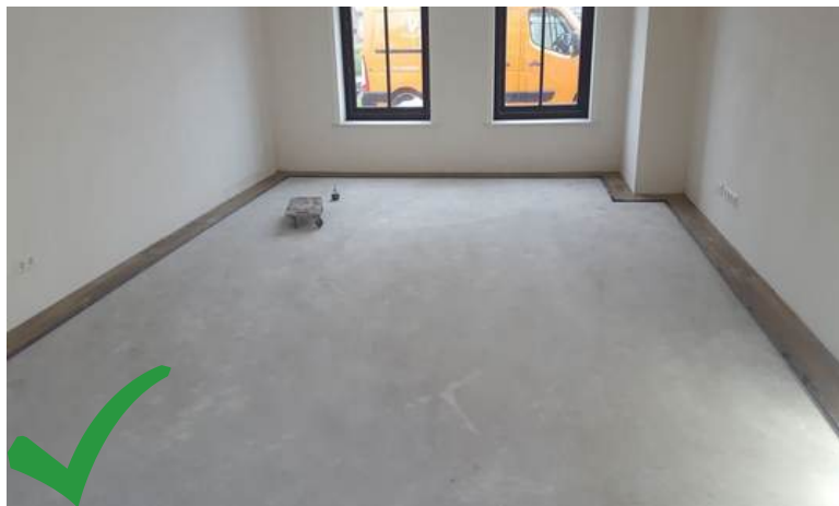
De zandcement dekvloer loopt te steil af.
