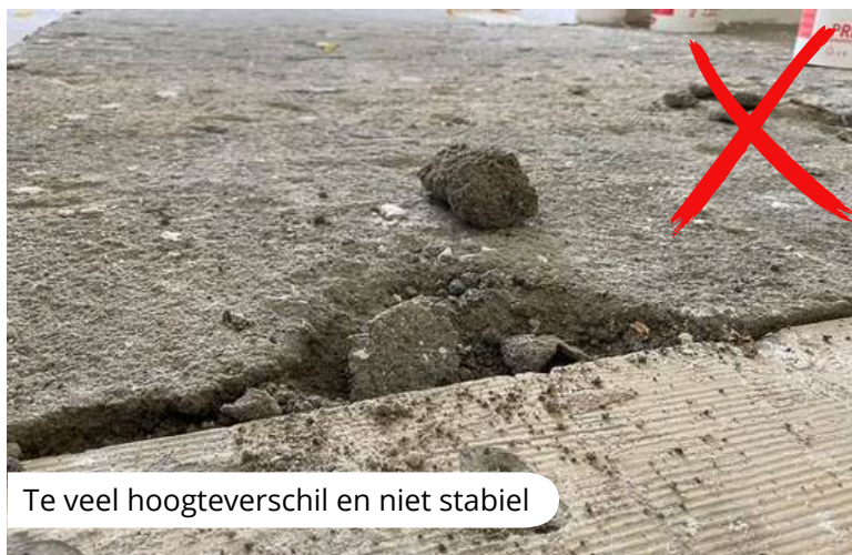
Te veel afloop en inzakkingen. Ook te grote scheuren
